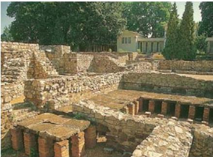
Система воздушных полостей для отопления пола и стен римских бань в Аквинкуме.
